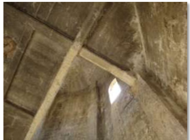
Внутри водонапорной башни. Очень хорошо сохранилась штукатурка. Фото 2010 г.
