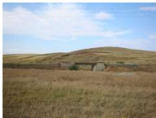
Мост за станцией Николаевской. Фото 2010 г.
